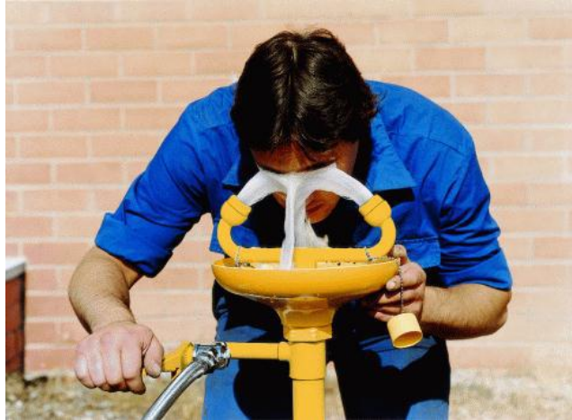
รูปที่ 11 แสดงเครื่องล้างตาแบบใช้มือผลัก (push bar)
